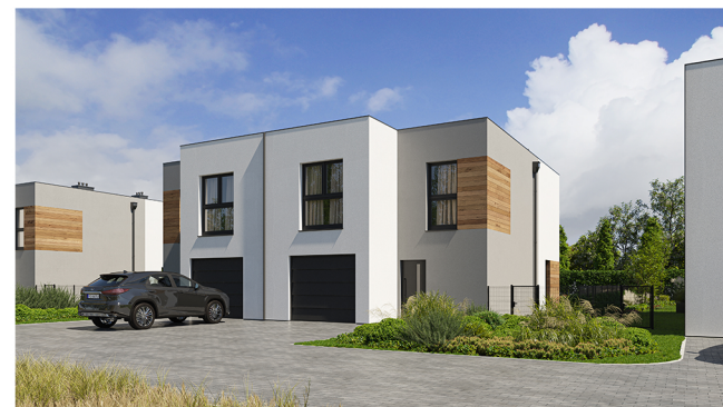
Widok od strony wjazdu na osiedle
